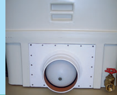
montierte LINN-Schleuse und Ablasshahn 2"
